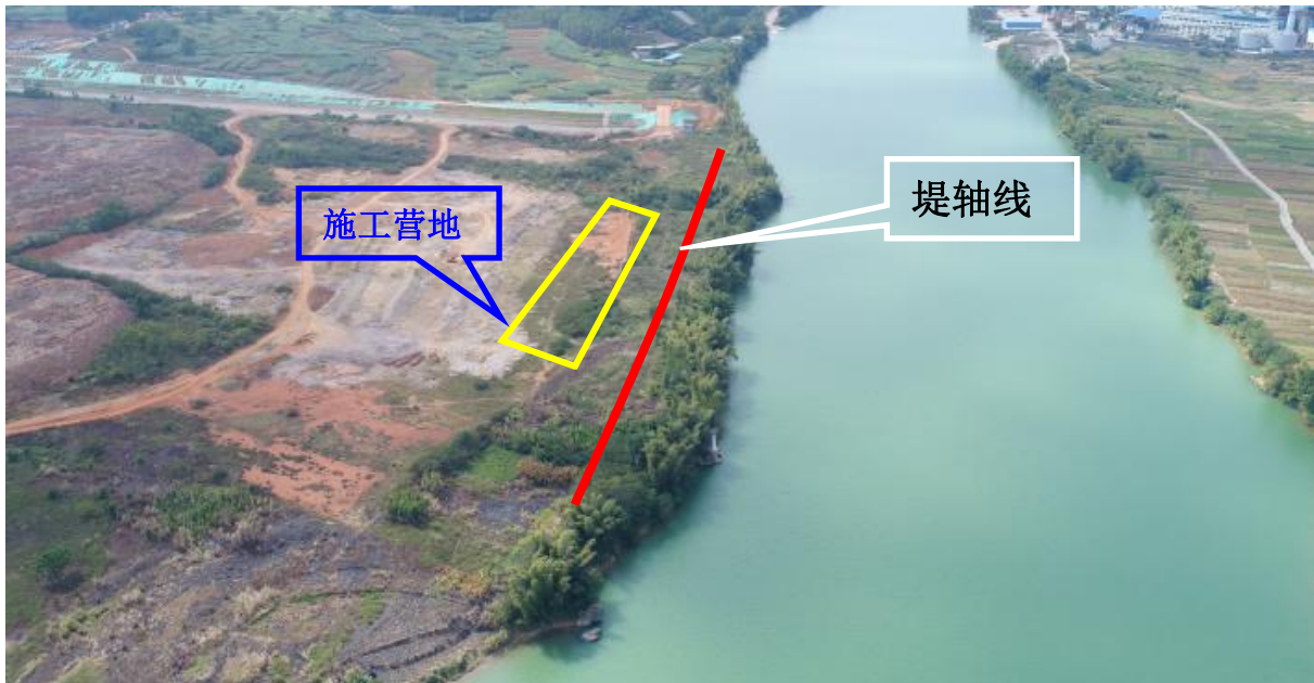
图 2.6-3 施工营地位置现状照片
