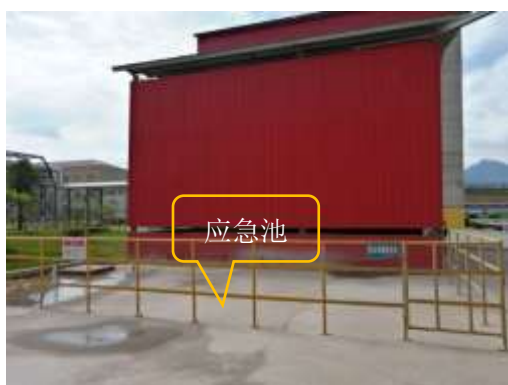
氨水罐区及应急池
